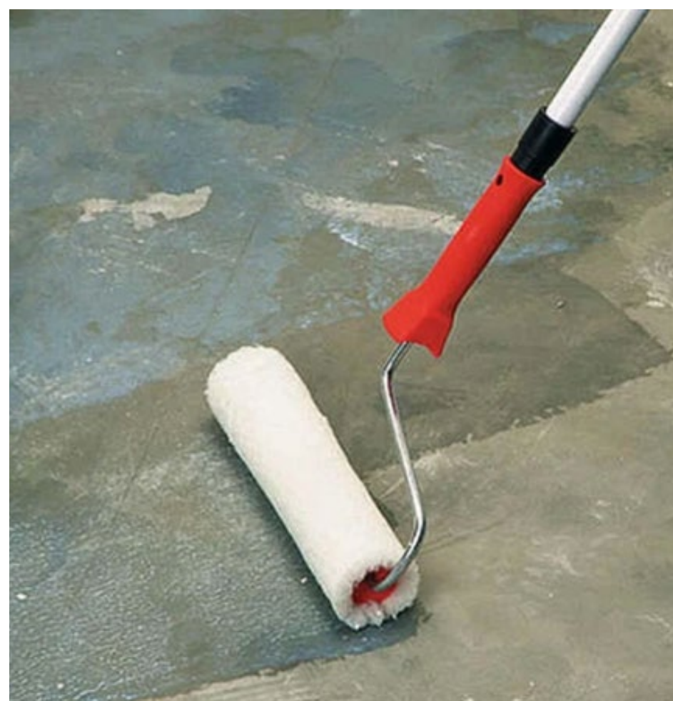
Нанесение грунта на основание
